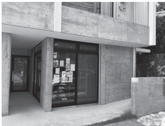
空きテナントとなっている場所を賃貸借
