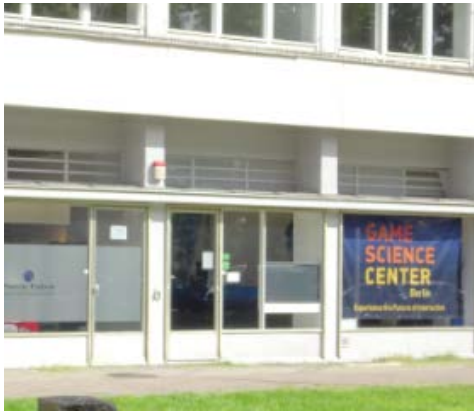
図 5-7 センターの外観
